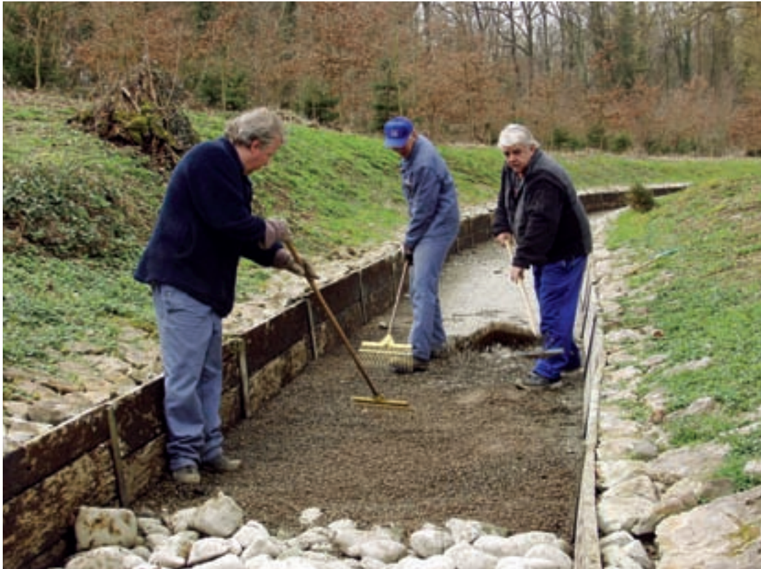
Reinigung Sickergraben Hard
